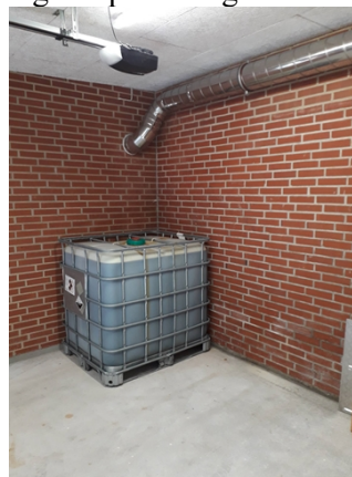
Tilbygning til opbevaring af kemikalie rum
