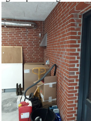
Tilbygning til opbevaring af kemikalie rum
