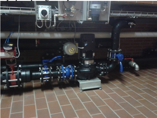
Nyt pumpe og rør system til filterne
